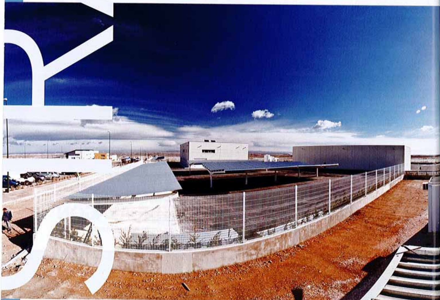
El Parque Tecnológico del Reciclado es la nueva ubicación de la planta de Zaragoza.
