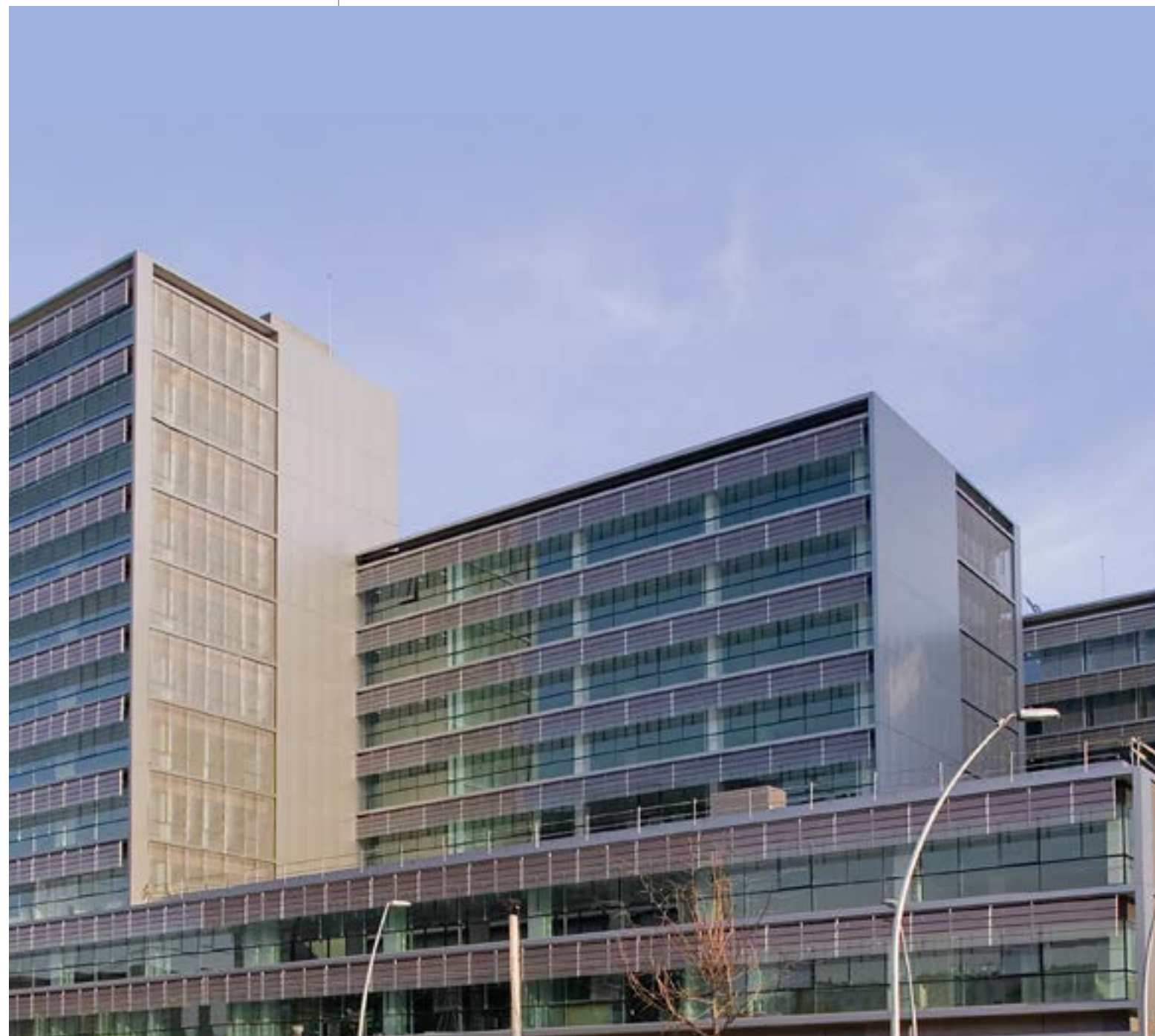
Edificio de oficinas INBISA Diagonal 22@ Barcelona
